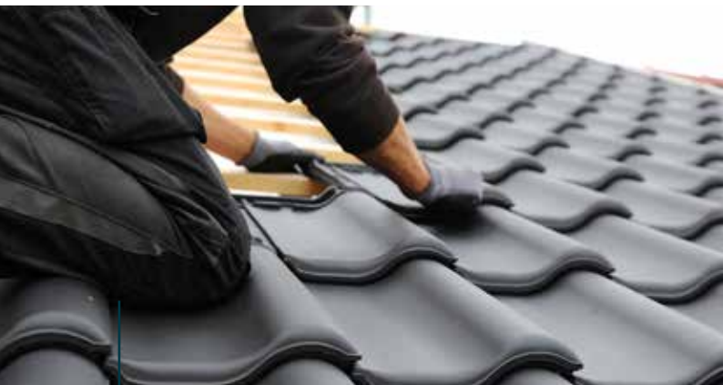
Die Regelungen zur Arbeitszeiterfassung seien nicht wirklich umzusetzen, sagt ZVDH-Präsident und Dachdeckermeister Dirk Bollwerk.
